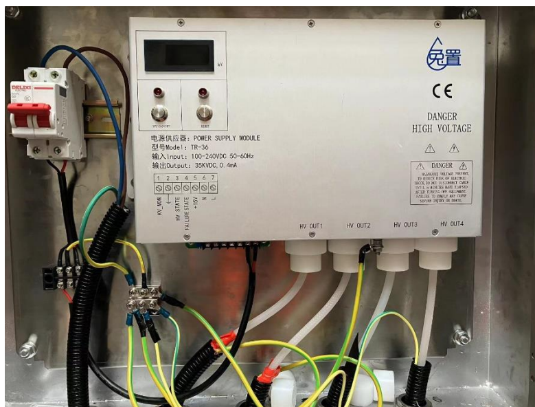
图6-2 配电箱高压输出接线图
